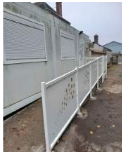
REPLACEMENT DE LA PASSERELLE RÉALISÉE PAR RÉMY ROQUET, ÉBÉNISTE ET L'ENTREPRISE POMMIER
